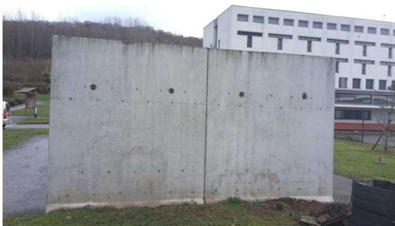
La face arrière du mur du basket, à son état initial.
